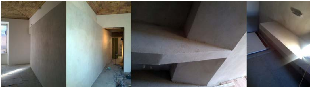
2011 Progetto di ristrutturazione di un alloggio (90 mq), via Arenula, Roma
